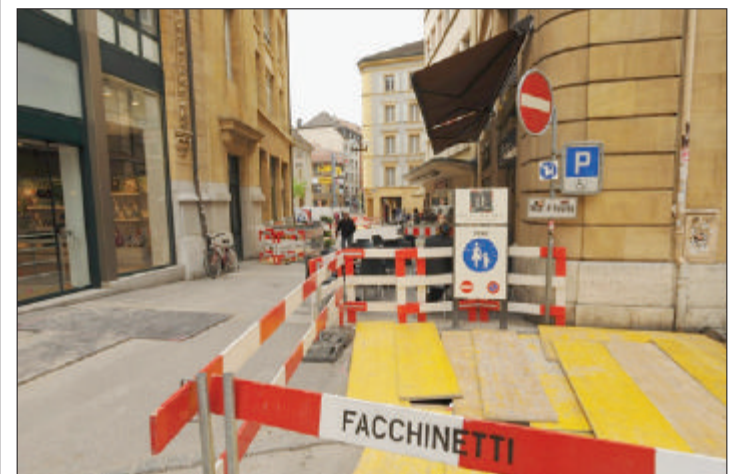
NEUCHÂTEL Il n'y aura pas de travaux dans la zone piétonne pour les festivités du Millénaire. Ou très peu. (ARCHIVES RICHARD LEUENBERGER)
